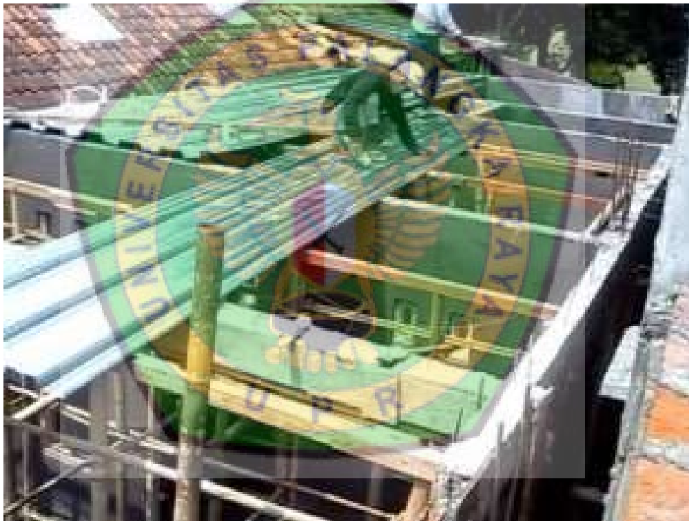
Gambar 2.4 Konstruksi Pelat Lantai Menggunakan Floordeck
